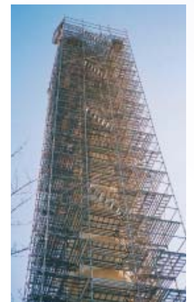
日清紡名古屋工場煙突解体
